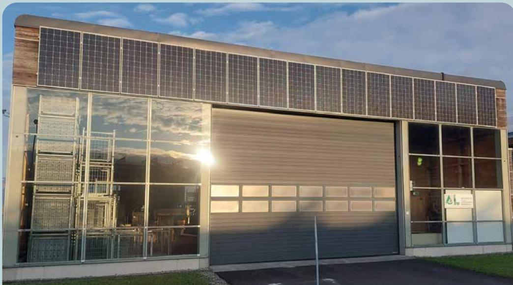
Abbildung 5: Anordnung der Photovoltaikpaneele am Bauhof Liezen (Foto: WLW, GBL Steiermark Nord)
