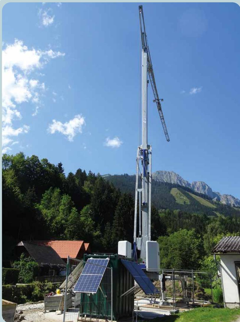
Abbildung 2: Mobile Baustromversorgung als Photovoltaikanlage mit Drehstrom zum Betrieb des Baukranes (Foto: WLV, GBL Steiermark Nord).
