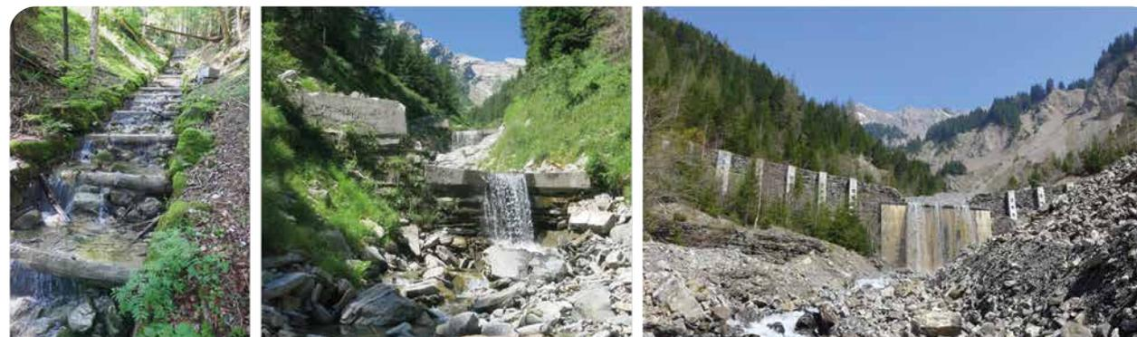
Abbildung 6: Schutzbauten in verschiedenen Wildbächen. Links: kombinierte Stein-Holzschwells im Nasenbach (Flussbau AG SAH 2013), Mitte: Sperre im Val de Gervan, Ri del Bess (AFRY Svizzera SA 2020), rechts: Sperre im Einzugsgebiet des Lammbachs (Mätzener & Wyss et al. 2018).
